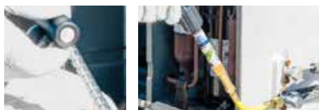
Inyección de tinte girando la manija.
