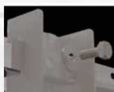
4. Fijación de la barra y brazos verticales con tornillos TH CL.8.8
